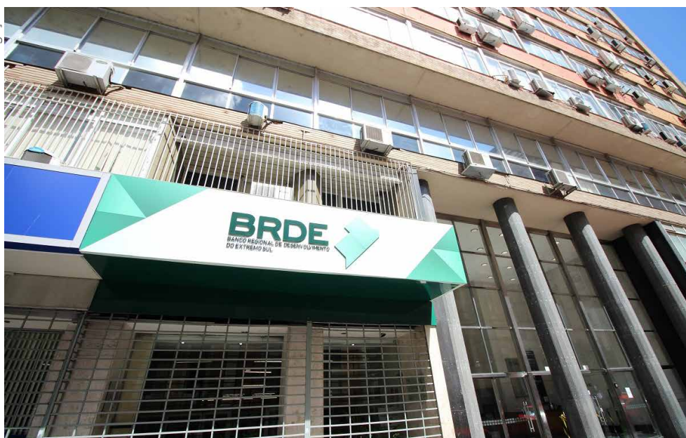
Fachada da sede do BRDE (Banco Regional de Desenvolvimento do Extremo Sul) em Porto Alegre (RS)
