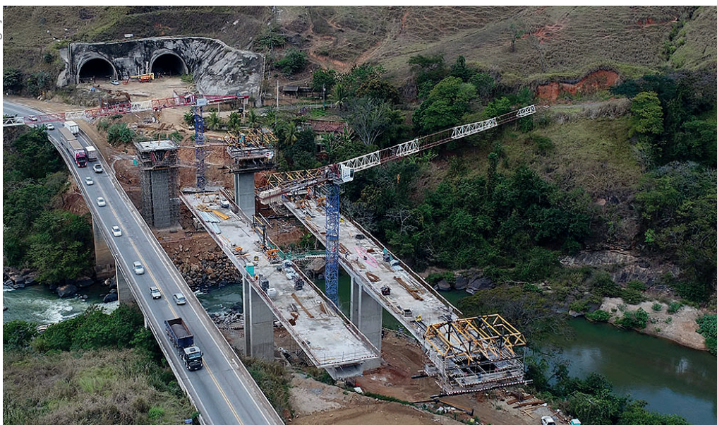
“Áreas como o transporte rodoviário e a logística, por exemplo, exigem contrapartidas e garantias públicas que viabilizem parcerias de longo prazo e execução célere de projetos.” Na foto, obras de duplicação da rodovia BR-381 no município de Antônio Dias, em Minas Gerais, iniciadas em abril de 2026
