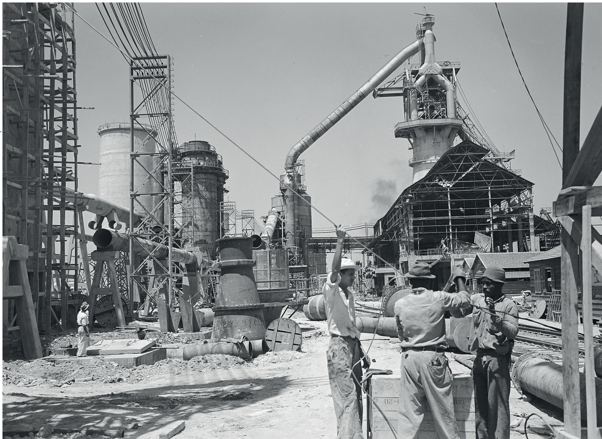
Construção da Companhia Siderúrgica Nacional (CSN), 1941
