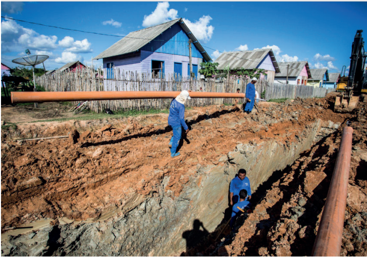
Os estados da Amazônia enfrentam o desafio de oferecer saneamento a moradores que chegam às novas cidades. Na foto, obra de saneamento em município do Acre
