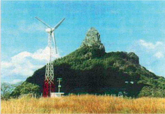
No Brasil, a instalação do primeiro aerogerador foi no arquipélago de Fernando de Noronha no ano de 1992
